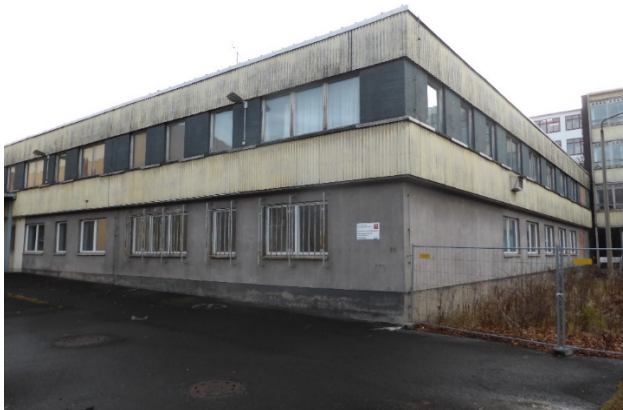
Abbildung 1: leerstehendes Gebäude unsaniert, 2020
